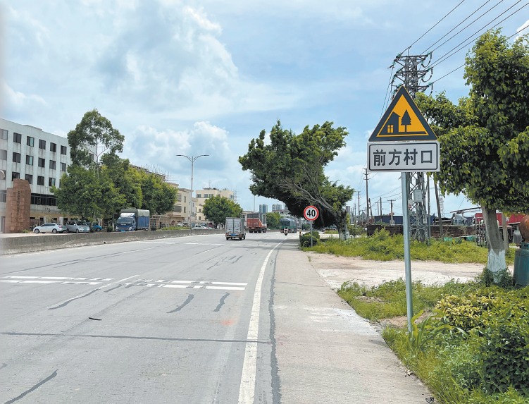
恩平市开展“平安村口”建设，村口加装了警示牌。
