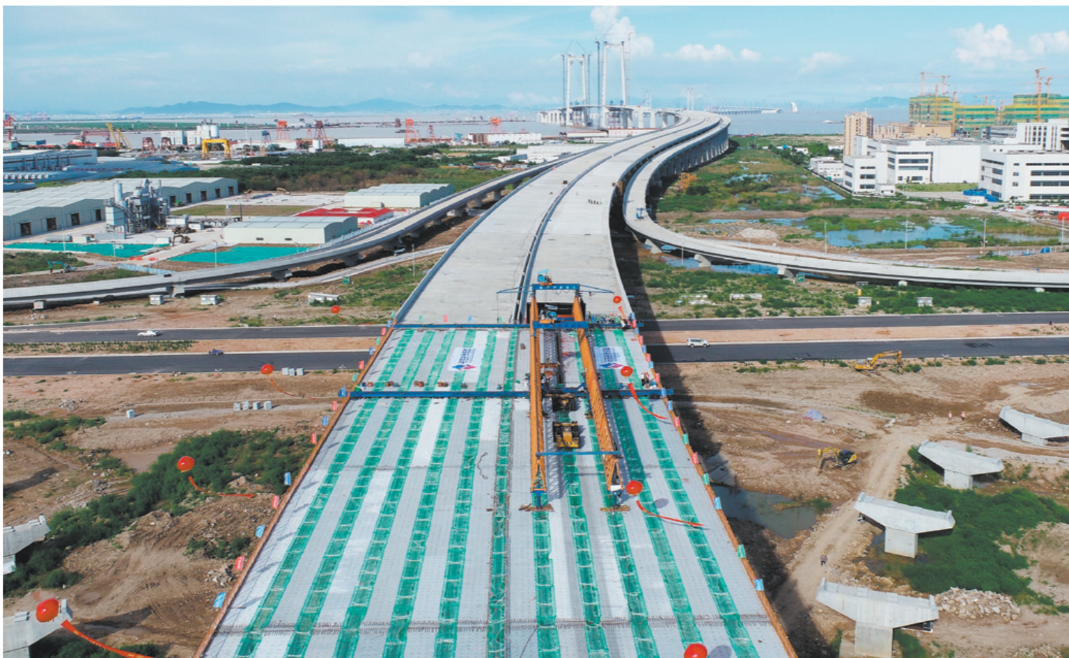
中开高速横门互通主线桥与深中通道实现顺利对接。
