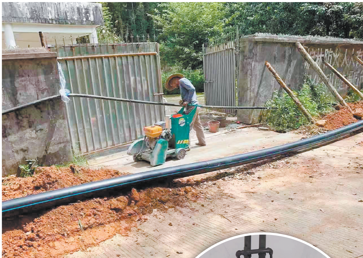
▲大沙西湾村供水工程加快推进,工人正在铺设管道。
