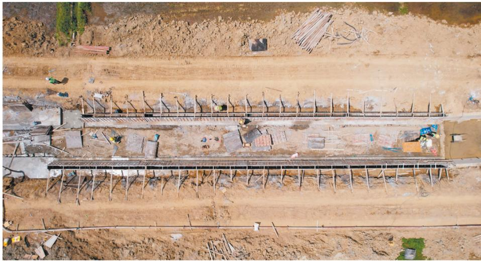
在桂南水库灌区续建配套节水改造二期工程施工现场,工人正在开展渠道混凝土护岸工程建设。
