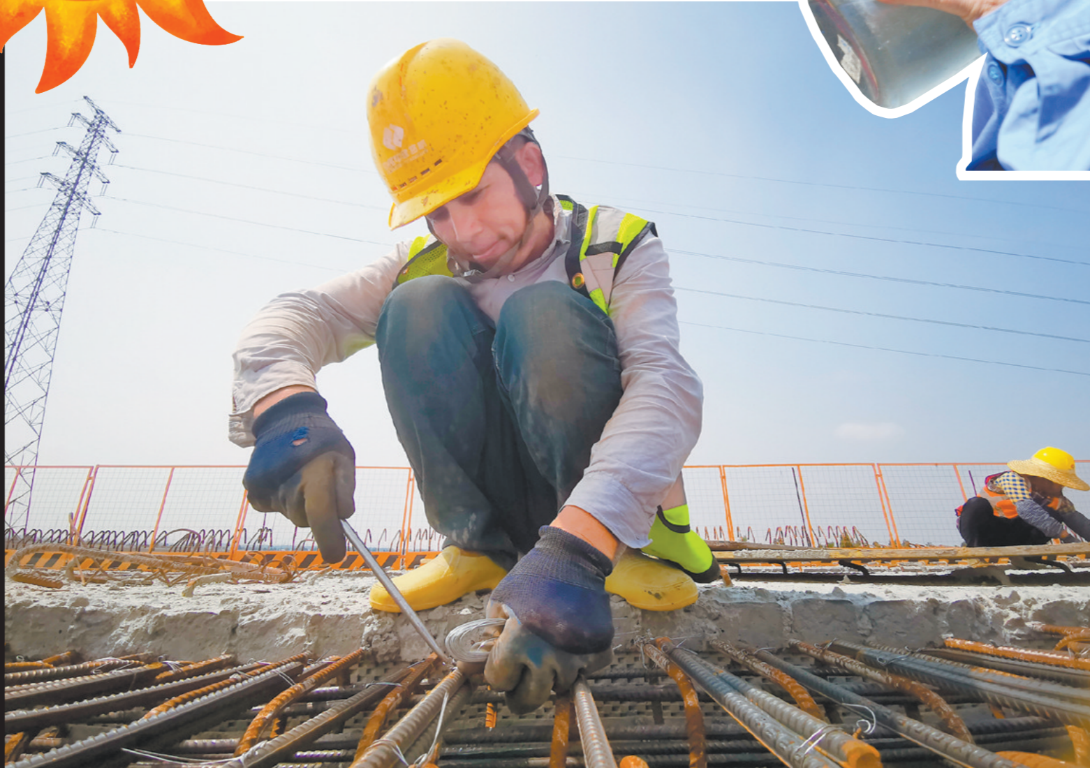
江海区礼乐一工地，道路工人顶着烈日作业。 郭永乐 摄
