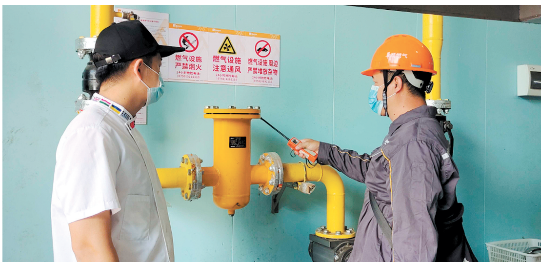
← 安检员检测餐饮场所燃气设备。
