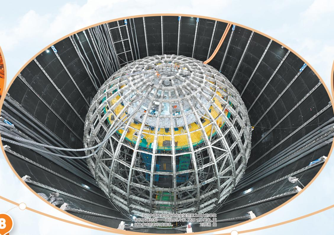
江门中微子实验装置能安装世界上最大的单球 有机硅球罩——直径38.4米,厚厚120毫米,重 800多吨的有机硅球罩。刘波摄
