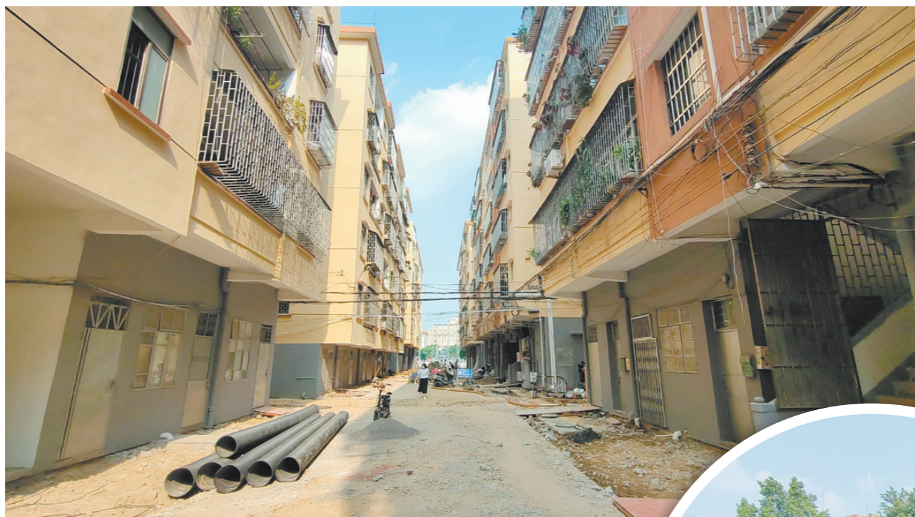
▲财贸新村正在进行下水道管网改造。
