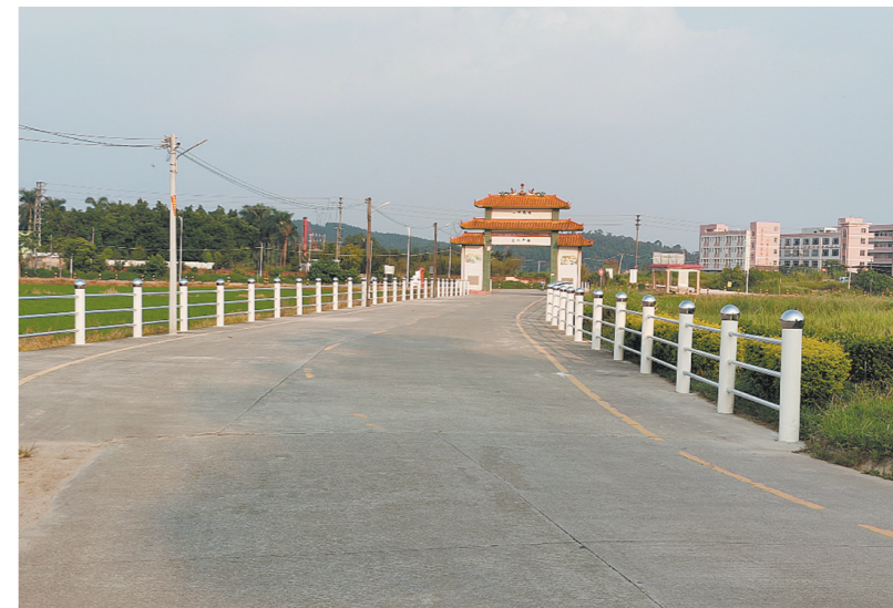
村道两旁装上防护栏，村民出行更安全。
