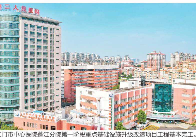
江门市中心医院蓬江分院第一阶段重点基础设施升级改造项目工程基本完工。
