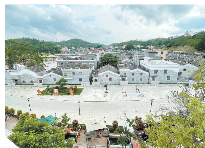
台城街道桂水村开展古侨建筑活化提质、村道扩建、公厕改造等工程,村容村貌越来越美。
