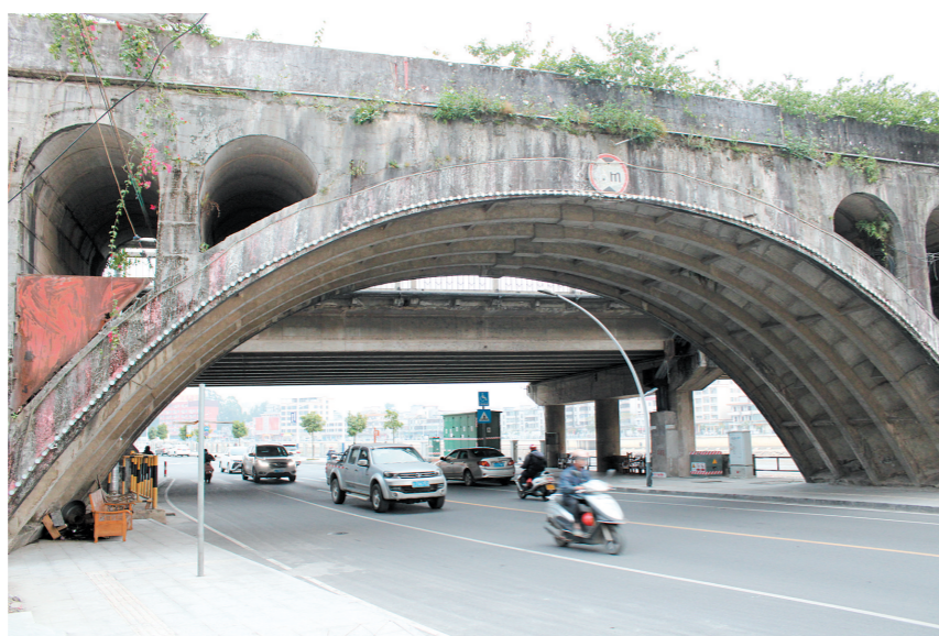
旧恩平大桥的桥孔为行人提供遮雨之地。
