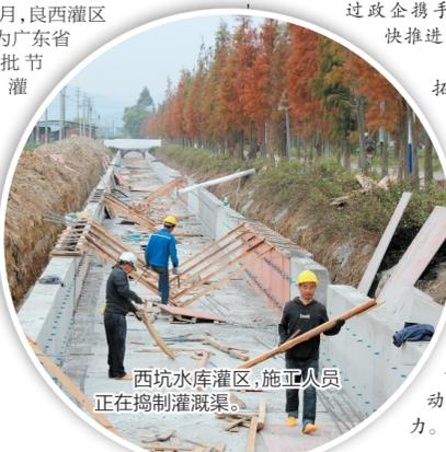
西坑水库灌区，施工人员正在捣制灌溉渠。
