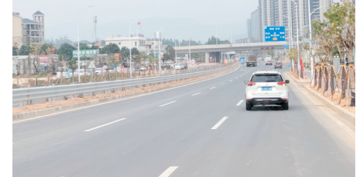
省道S270线鹤城至杜阮段扩建工程(鹤城小官田村至共和宝丰新城段)全线建成通车。
