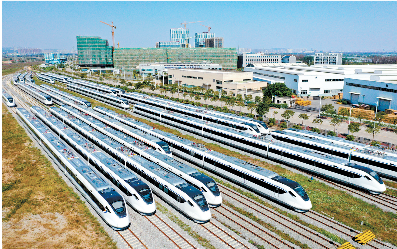
江门被列为高端装备制造战略性新兴产业集群的“核心布局”城市，正以中车广东基地为核心建设广东轨道交通产业园。 郭永乐 摄
