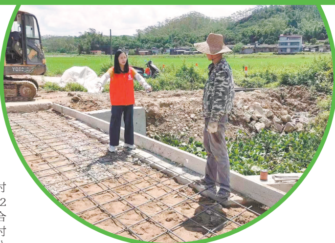
受伤也“闲不住”的陈小凤东奔西跑，争取到上级部门补助资金。过水涵修复工程得以迅速完工，消除了村民出行安全隐患。
