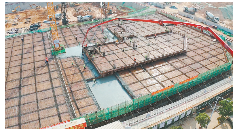
施工现场,一片热火朝天。
