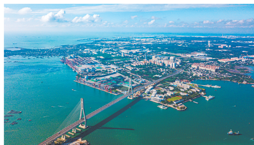
这是海南洋浦经济开发区(2022年11月6日摄，无人机照片)。新华社发
