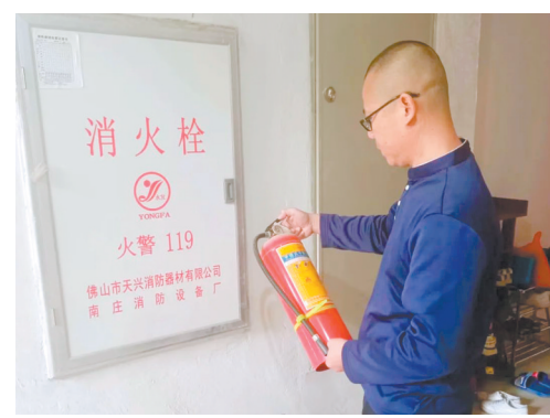
麦国平定期检查小区楼道的消防设施。
