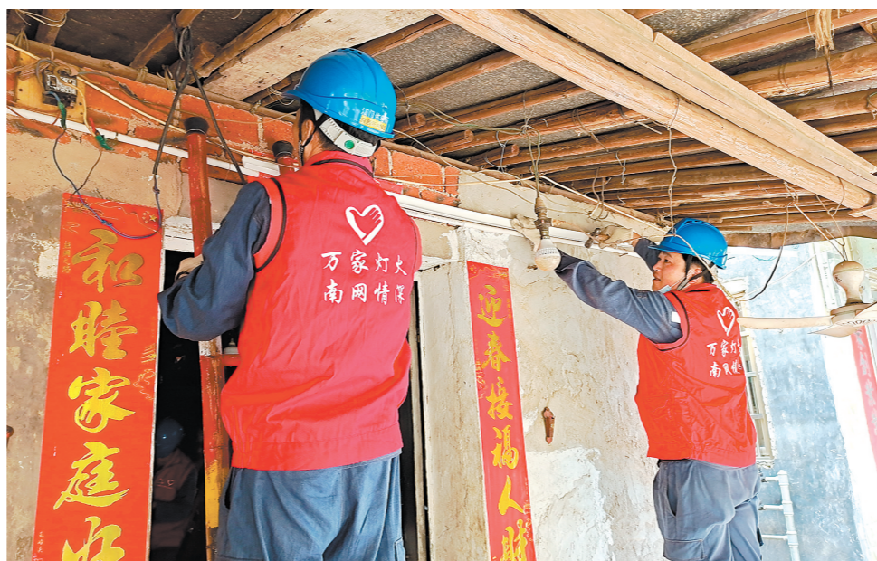
恩平市良西镇党员志愿者为高龄独居长者检查电路。
