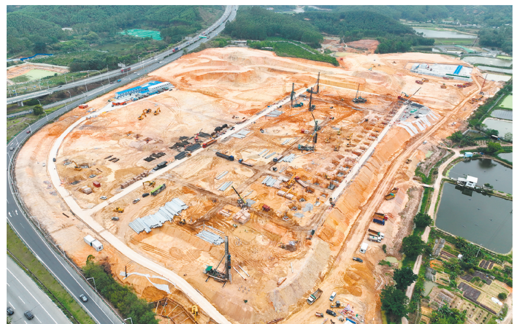
第一产业江门央厨及预制菜生产基地项目在蓬江区预制菜产业园(五洞园区)落地。
