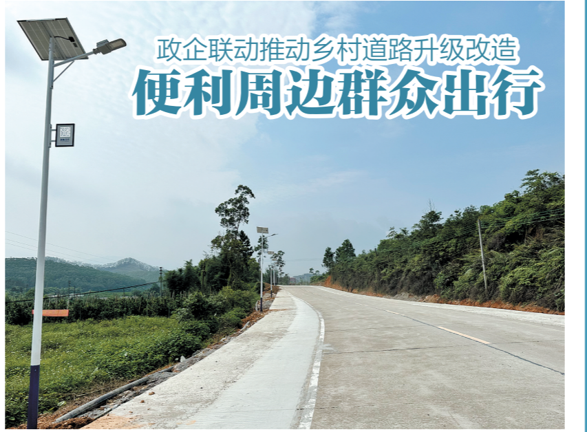
宅梧镇切实推动乡村道路升级改造。
