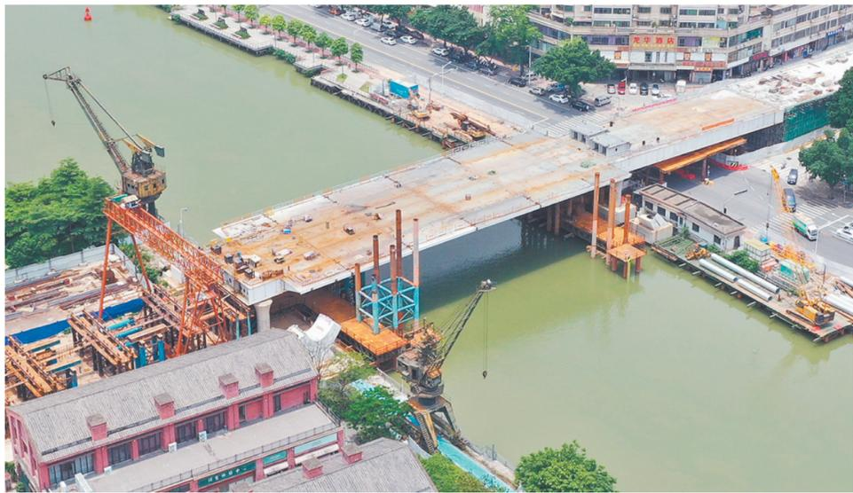
大桥合龙,标志着桥梁主体完工,下一步将进入桥塔及拱架、桥面施工,以及护栏安装、照明等配套附属工程施工阶段。
