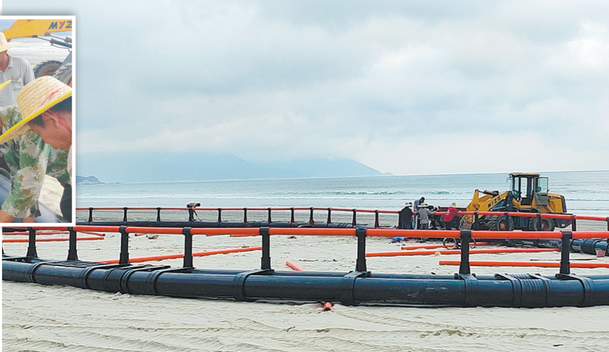
首批30个重力式网箱正在上川岛进行网箱框架系统组装工序。
