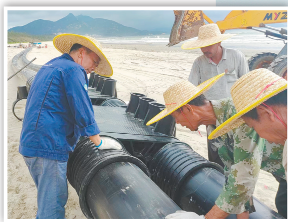
工人们正在组装网箱框架系统。
