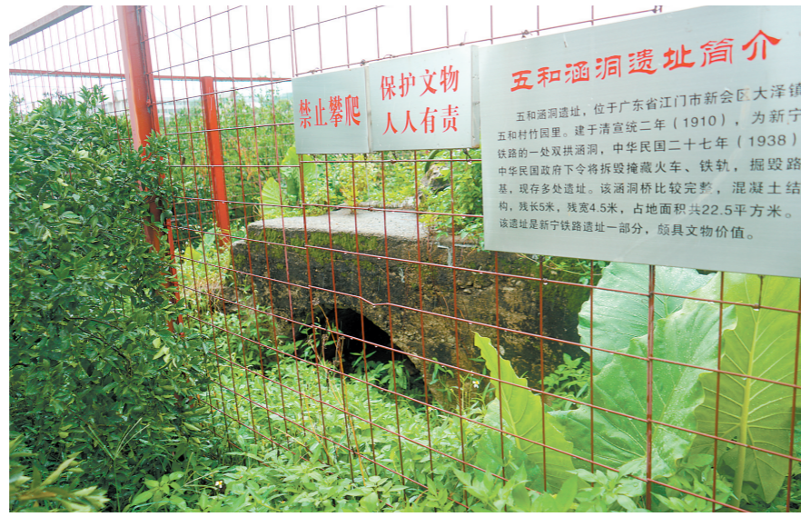
新宁铁路大泽段遗存的涵洞。
