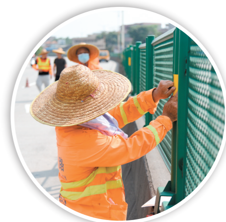
工作人员替换道路上残旧的反光警示贴纸。
