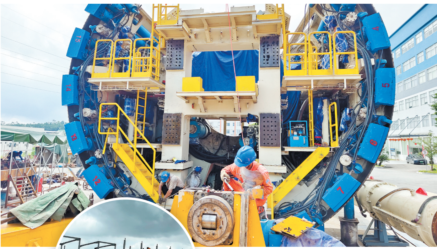
欣龙隧装盾构制造园项目顺利推进。郭永乐 摄
