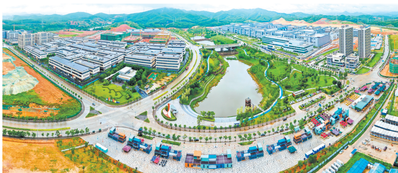
建设中的新会智造产业园凤山湖园区一瞥。郭永乐 摄
