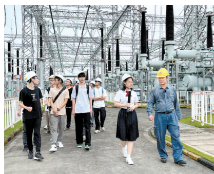
五邑大学学生及媒体记者参观500千伏江门变电站。
