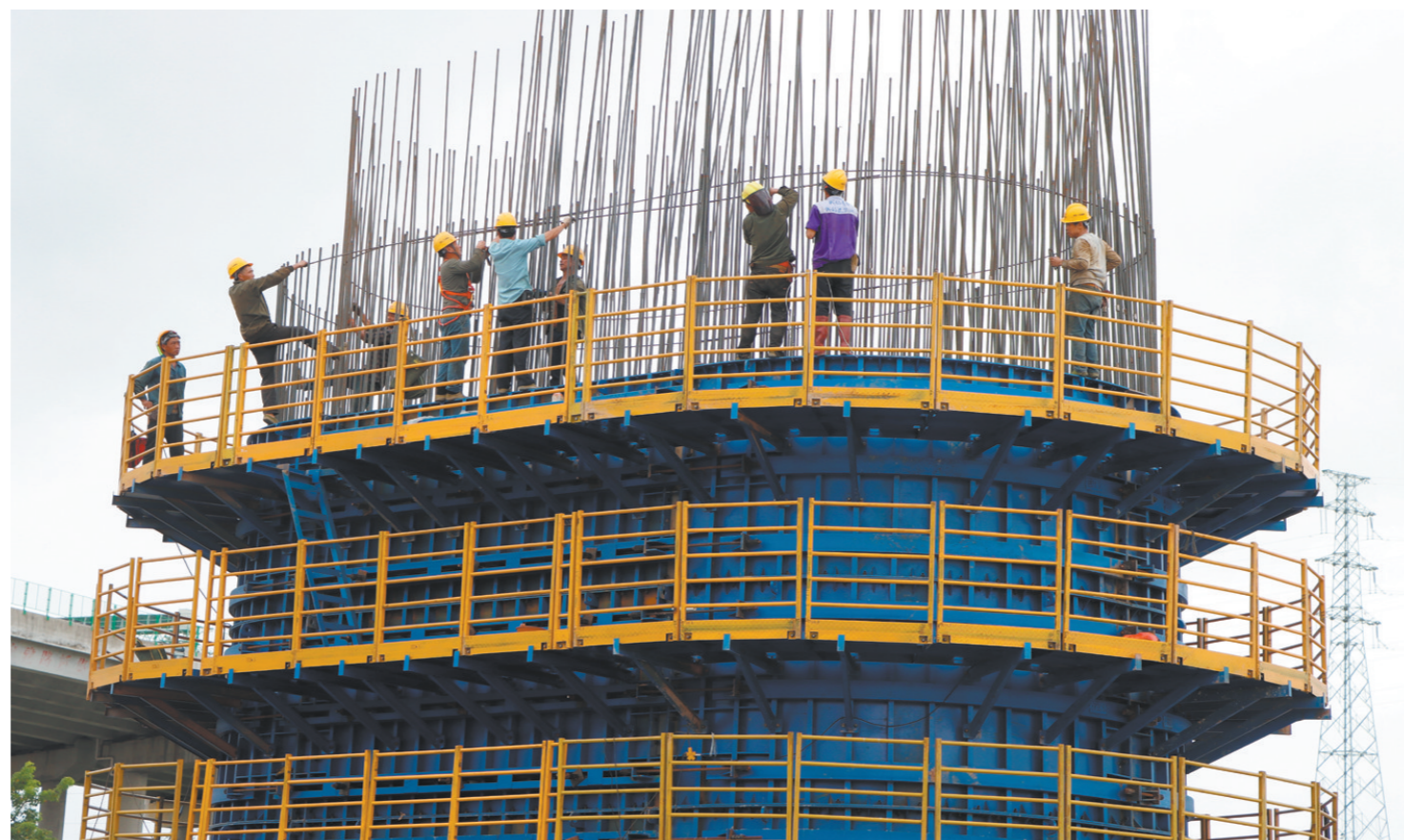
在深江铁路12标段,建设者们“双节”期间不休假、不停工。
