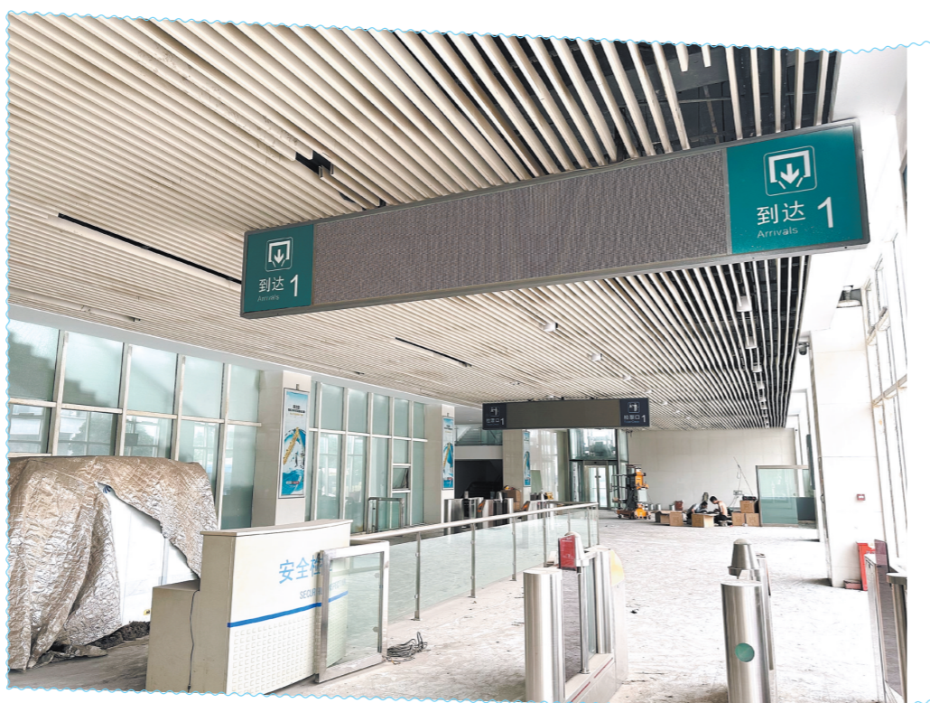
城轨礼乐站内大厅吊顶已全部翻新,各类指示牌一应俱全。
