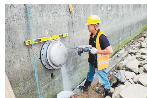
开平城区计划安装538个拍门，工人正在抓紧时间施工。
