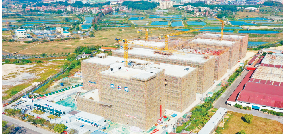
沙坪街道盘活低效用地，推动产业转型升级，位于沙坪街道的城乡融合发展产业园正在加快建设。
