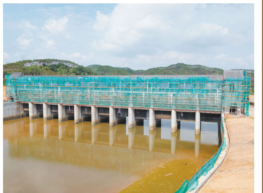
蓝田水闸重建工程总体进度已完成95%,接下来的重点工作是启闭室、管理房的装修工程,以及其他附属工程的建设,争取本月底完工。
