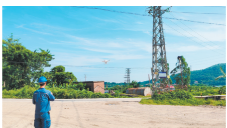
新会供电局运维人员操控无人机与地面监测视频实时“合作”,对线路设备及通道进行无死角、无盲区的精细化巡视检查。
