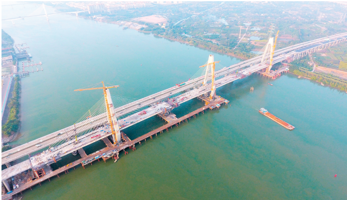
中江高速改扩建项目西江特大桥主桥顺利合龙,为全线实现通车目标奠定了坚实基础。
