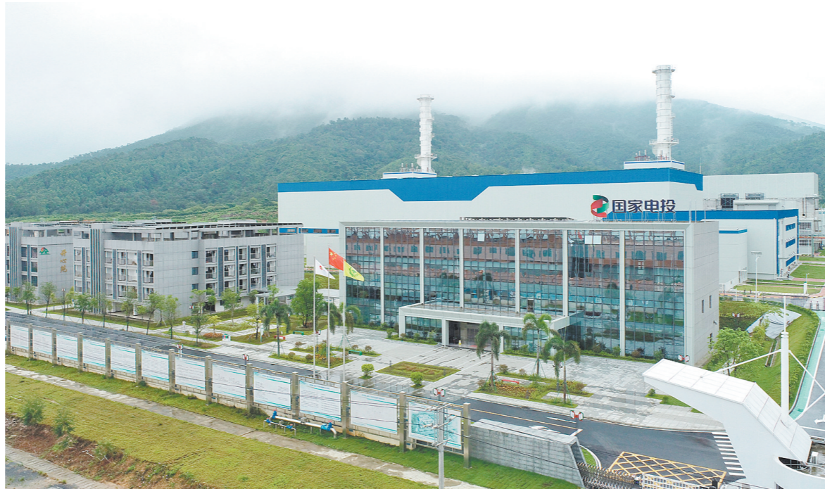
今年,国家电投开平山热电厂燃气项目1、2号机组顺利实现投产。徐刚 摄
