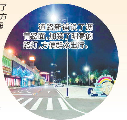
道路新铺设了沥青路面，加装了明亮的路灯，方便群众出行。
