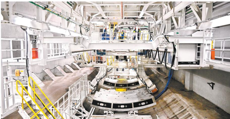
青岛胶州湾第二隧道连接青岛主城区和国家级新区青岛西海岸新区，设计时速80公里。工程全长17.48公里，其中主线隧道长14.37公里，包括长达9.95公里的海域段。此次盾构机由青岛港码头向西海岸掘进，将与钻爆段隧道对接，并在海底洞室内进行盾构机接收、拆解。
