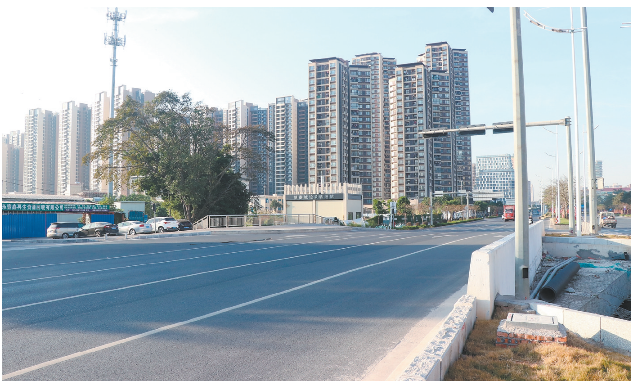
重建后的赵家围桥桥面宽阔、平整。
