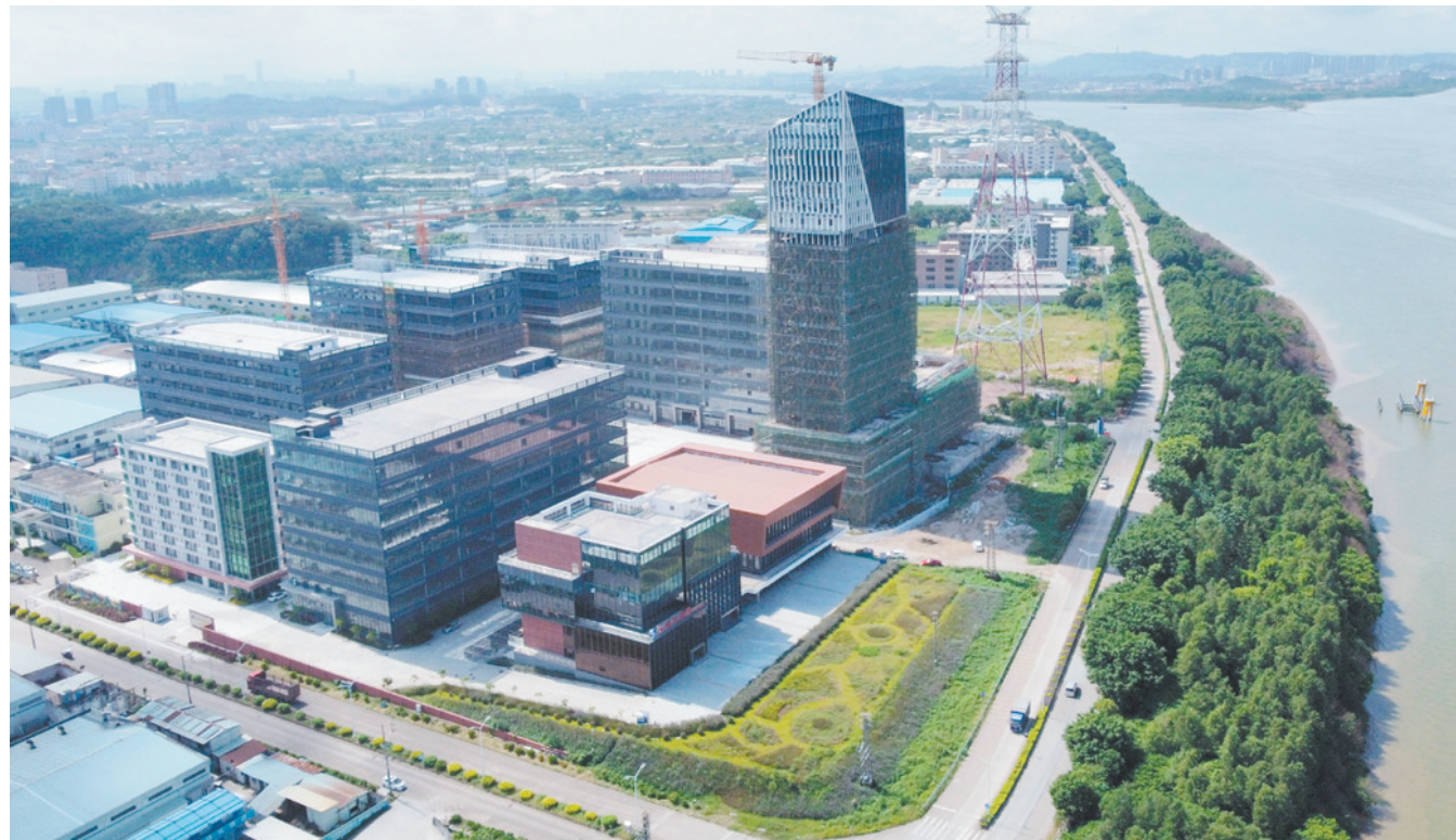
荷塘镇将抢抓“大桥经济”“黄金内湾”历史机遇,奋力建设产城融合宜居示范镇。图为位于荷塘镇的深圳科技园江门园区。
