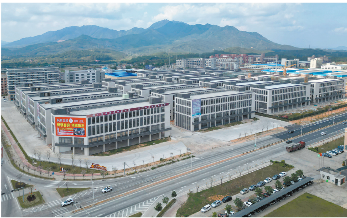
恩平工业园以“工业振兴”“园区再造”“科技引领”三大工程为主线,全力抓好“增总量、调结构、提速度、优服务”四项工作,发展态势持续向好。图为园区内的升泰昌·恩平智造加速器项目。企业供图
