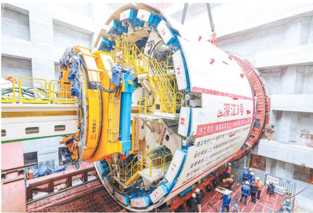
2月28日，在由中铁十一局承建的深江铁路深莞隧道西段，“鲲鹏号”盾构机刀盘吊装下井，该段是13米级大直径单洞双线隧道。深江铁路是我国“八纵八横”高铁网沿海通道的重要组成部分，正线全长约116公里。
