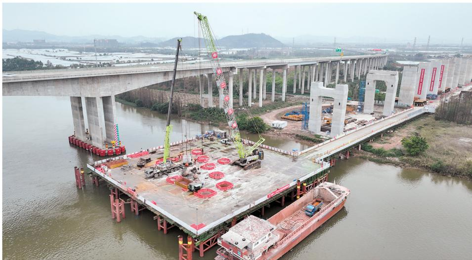
机械在跨虎跳门水道特大桥梁主塔桩基础施工现场作业。
