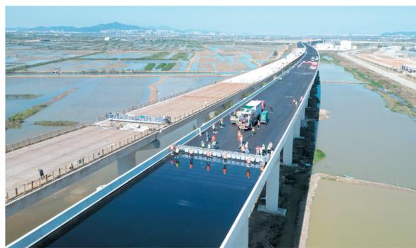
江门日报讯(文图 记者 毕松杰 通讯员 黄鸣子) 近日,黄茅海跨海通道项目全线首个环氧沥青铺装试验段在东升桥混凝土桥段顺利完工(上图)。试验段长度为200米,包括AC-13调平层、防水粘层、环氧沥青铺装下层、粘层和环氧沥青铺装上层五道施工工序。
