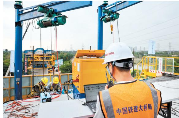
3月31日,中铁建大桥局运用全线首台多功能智慧造桥机,浇筑完成深江铁路跨105国道沙溪特大桥首节连续梁。对比传统挂篮悬臂浇筑施工,智慧造桥机有效降低高空作业的安全风险,并提高拼装效率。
