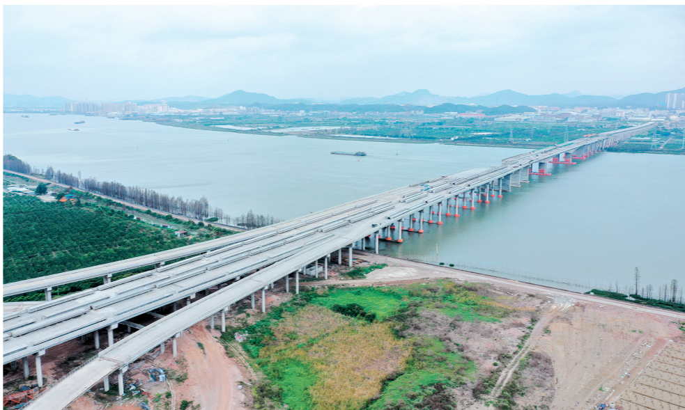
潭江特大桥是银洲湖高速公路重点控制性工程之一,计划今年7月全桥贯通。
