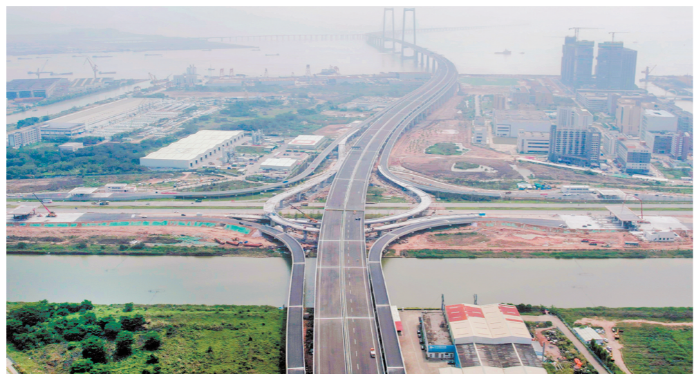
中开高速对接深中通道出路面行车道已经开始划线。
