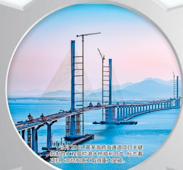
3月20日,黄茅海跨海通道项目关键控制性工程高栏港大桥顺利合龙,标志着项目上部结构施工取得重大突破。
