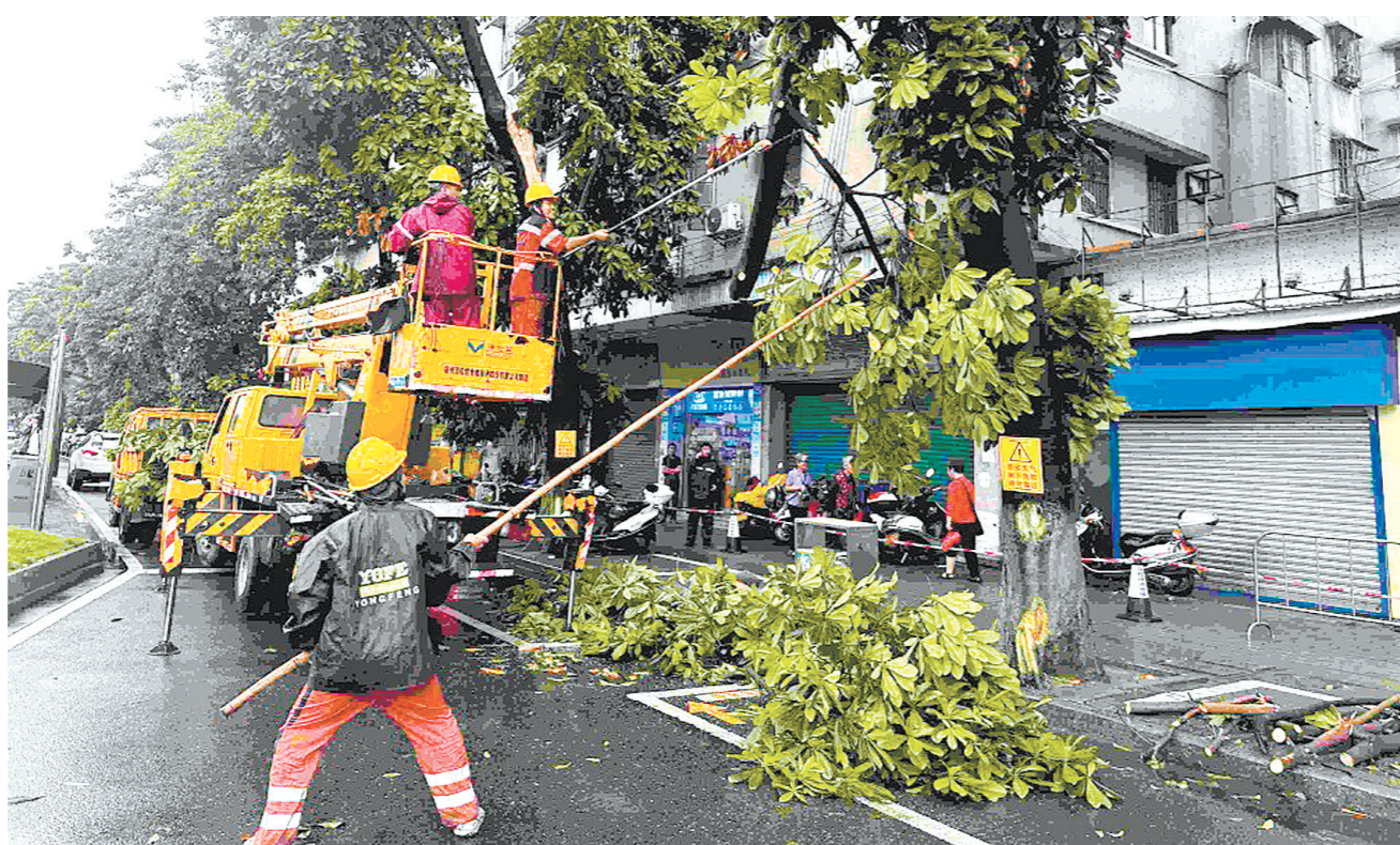
园林工人使用高空作业车处理断枝,消除安全隐患。
